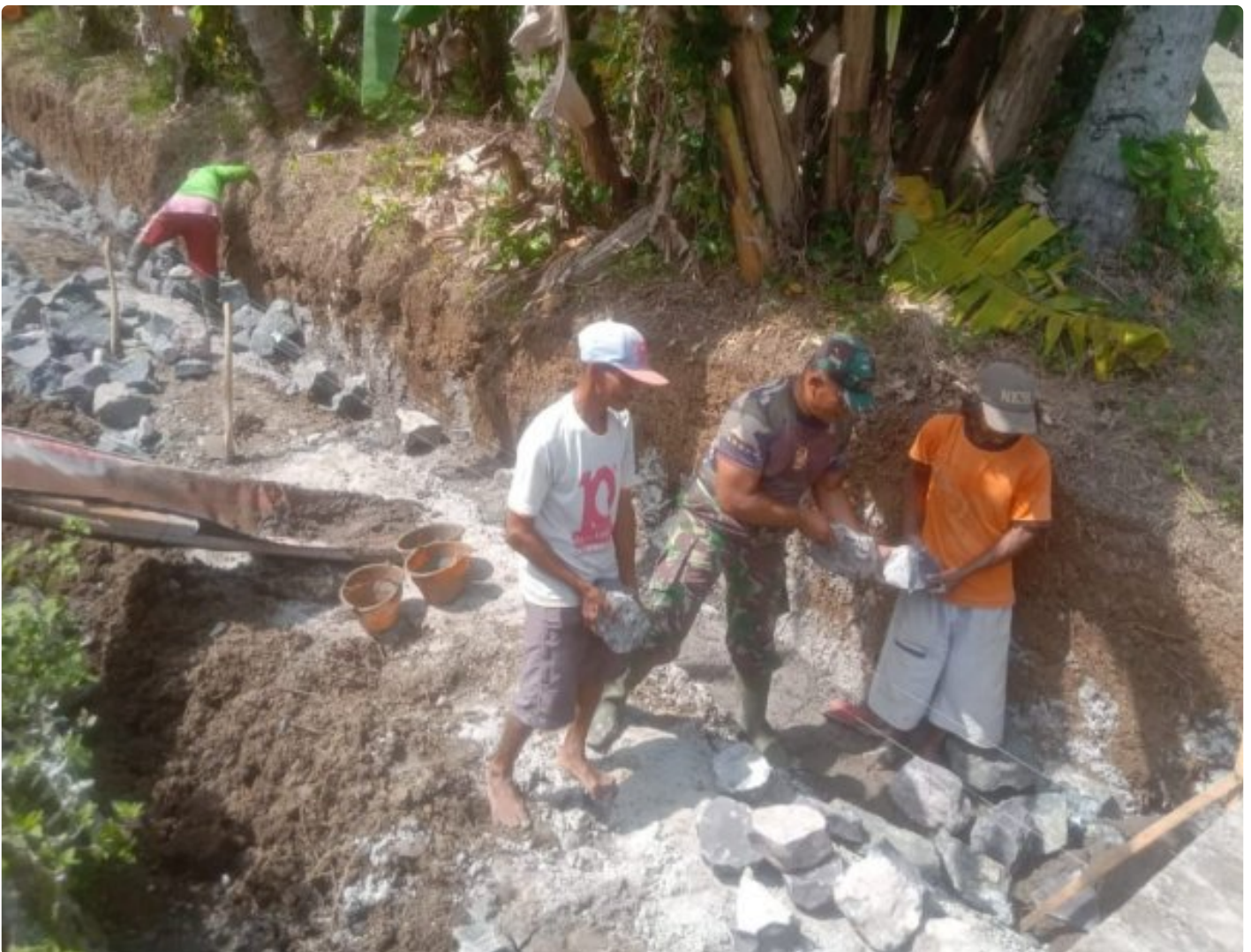
Babinsa Koramil 19/Kuwarasan Sertu Suratno Melaksanakan Giat Karya Bhakti Pembangunan Talud Irigasi Sepanjang 100 Meter.
